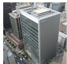
ろうきん肥後橋ビル
