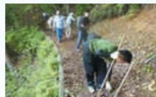
《環境保全》奈良・野迫川村の道普請 (古道の修繕・維持)
