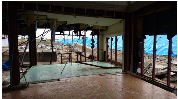
【一般社団法人 めるくまーる】 すぐ近くの吉田川が決壊し、床上約2メートルの浸水被害 を受け、床は泥まみれ、壁は剥がれ落ち床の一部が崩れた。
