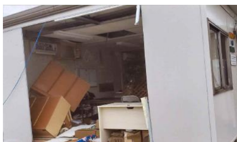
【ライフサポートピュアジャパン】 建物の窓ガラスも割れ、浸水も床上70cmに達し冷蔵庫などの備品もだめになった。
