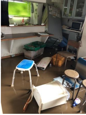
【社会福祉法人 にんじん舎の会】 阿武隈川が氾濫。デイセンターが 2m 浸水し、 移転が必要となった。
