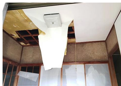
【NPO法人 たからばこ】 屋根の一部が飛ばされ、天井は剥がれ落ちる箇所もあり、床は全面水浸しとなった。
