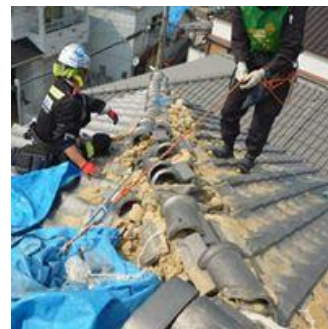
レスキューアシスト 障がい者、高齢社宅を中心に屋根の被害があったところに、ブルーシーを貼る作業をしている。
