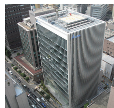
ろうきん肥後橋ビル
